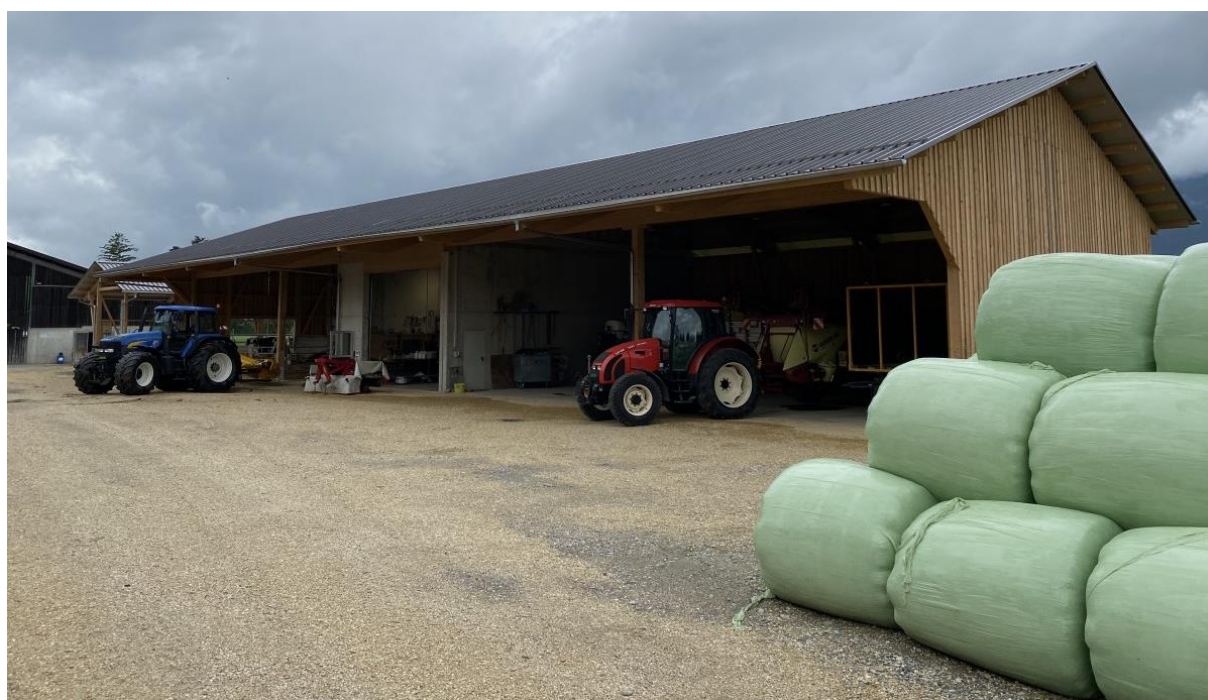
Neubau Remise und Galtkuhstall, Talgebiet
