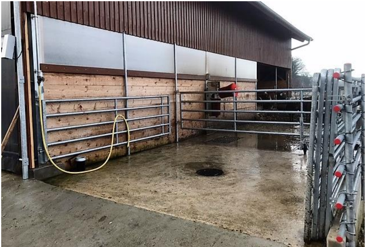
Füll- und Waschplatz für Feldspritze, Talzone
