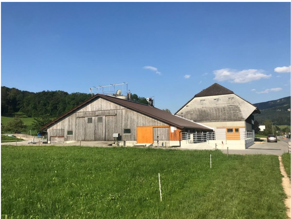
Umbau Milchviehstall in Mutterkuhstall, Talzone
