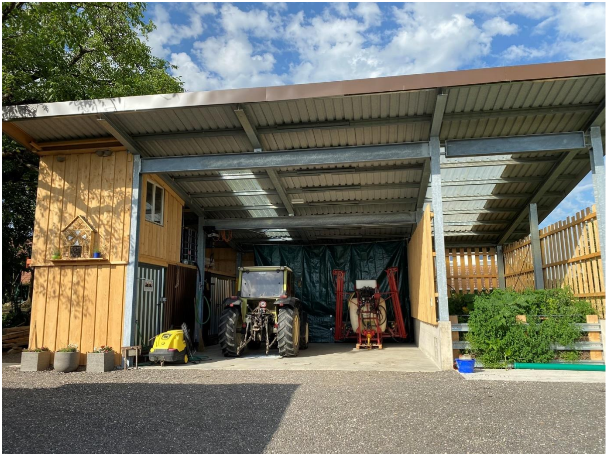
Füll- und Waschplatz für Feldspritze mit Biofiltration des Waschwassers (rechts), Talzone
