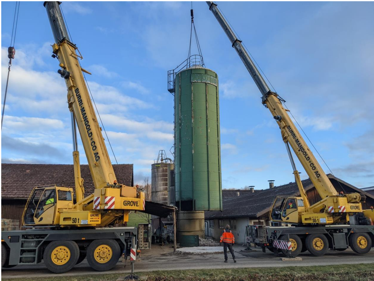
Der Rückbau von Ökonomiegebäuden, hier ungenutzte Hochsilos, kann unterstützt werden.
