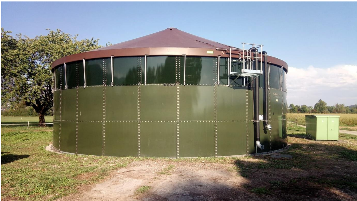
Aufstockung und Abdeckung eines bestehenden Güllesilos, Talzone
