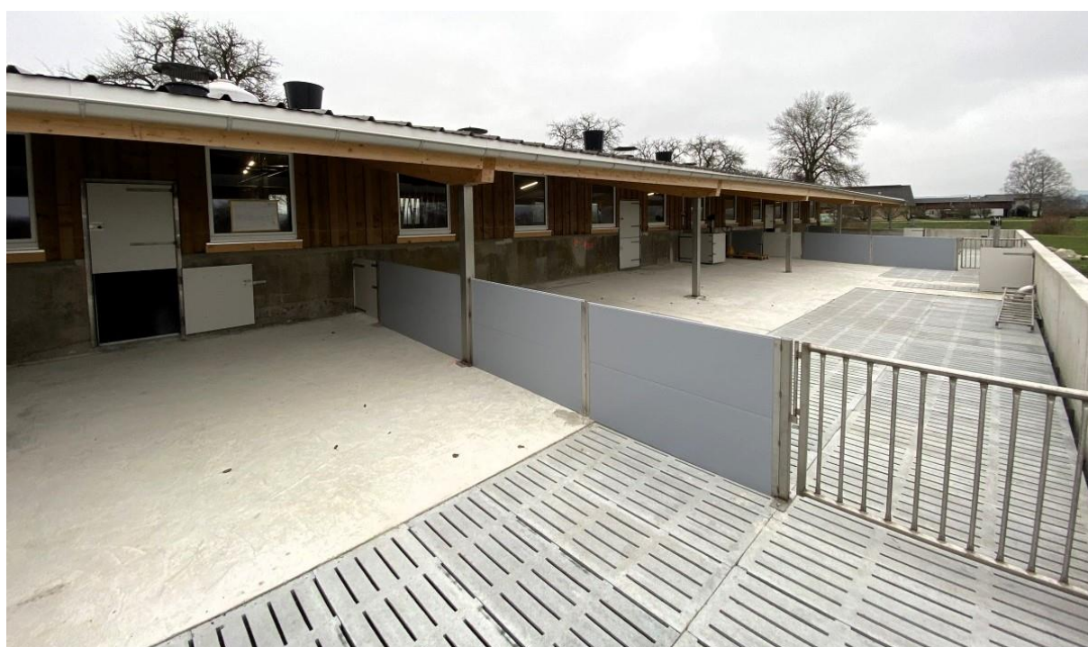
Sanierung Schweinemaststall mit Auslauf, Talzone
