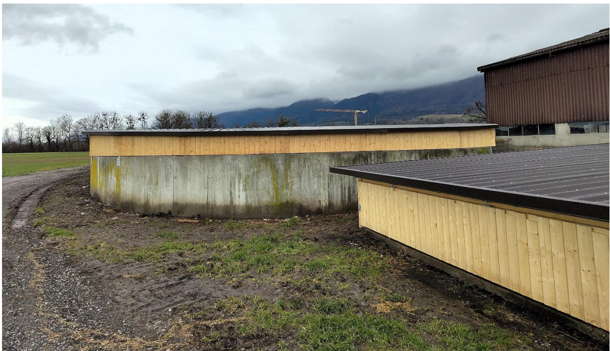
Holzabdeckung für bestehende Güllegruben zur Reduktion der Ammoniakemissionen, Talzone
