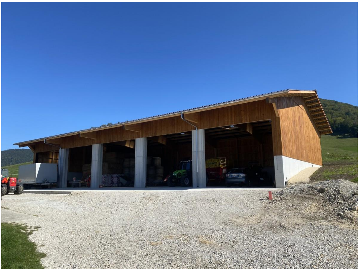
Neubau Remise, Bergzone 2
